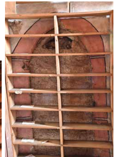
Der frühere Außenzugang: zugemauert und durch Bücherregale verdeckt
