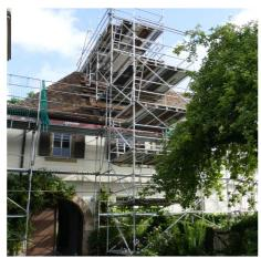
Da unsere Ziegel am Pfarrhaus in einen immer schlechteren Zustand kommen, wurde eine Dachsanierung nötig. Grund dafür ist, dass die Feuchtigkeit wegen einer ungünstigen Konstruktion des Dachstuhls nicht entweichen konnte. Außerdem sind zwei Balken, die den Turm auf dem Dach tragen, inzwischen so schadhaft, dass der Turm irgendwann abzustürzen droht.
